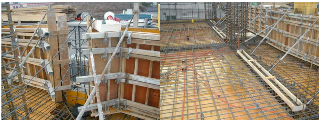
バルコニー手すり部分の型枠組立て状況 複雑な形状により施工性が悪くなっている
